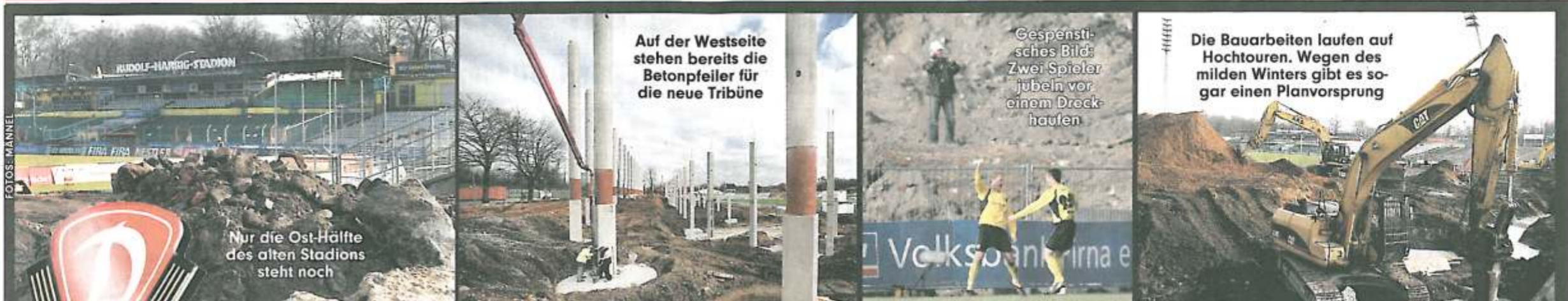
Nur die Ost-Hälfte des alten Stadions steht noch
